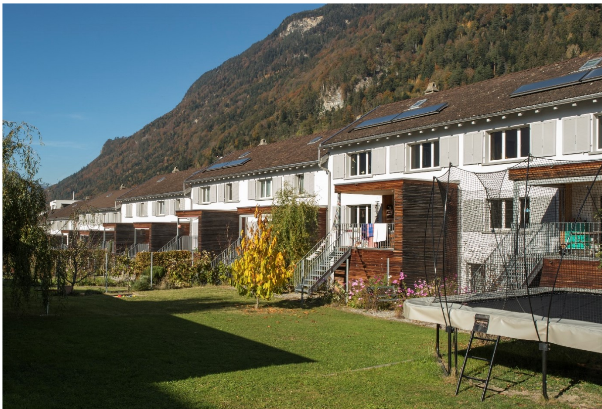
Ex insediamento residenziale per lavoratori di Turmmatt ad Altdorf (UR): alcune delle case a schiera ristrutturate, a cui è stato tra l'altro aggiunto un annesso in legno.
